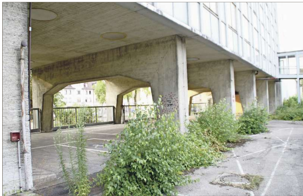
Das Freigeschoss samt Stützen sollte ursprünglich vollständig verglast werden – jetzt soll die Lobby des Hotels Richtung Innenhof verschoben werden. Foto: Fritsch
