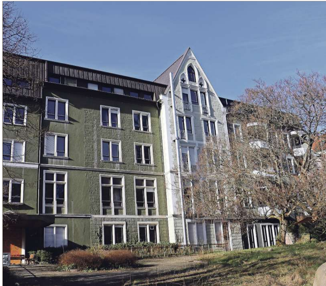
Auch der Abriss des früheren Pflegeheims in der Innenstadt ist Bestandteil des Genehmigungsverfahrens.
