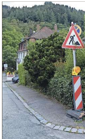
Minibaustelle mit eigenem Hinweisschild. Foto: Mütterlein
