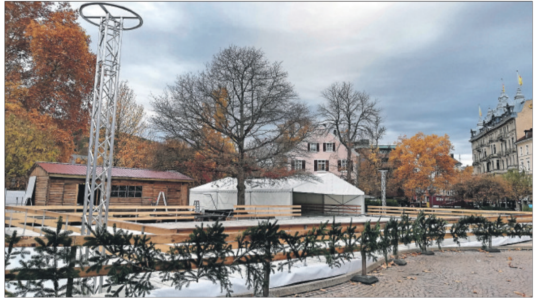
Die Aufbauarbeiten sind weit gediehen. Die Eisarena auf dem Augustaplatz lädt ab dem kommenden Samstag wieder zum Schlittschuhlaufen ein. Foto: Alina Meier
